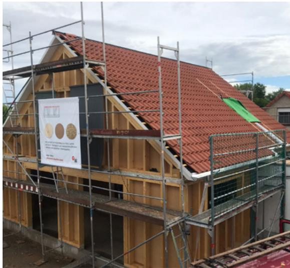
Das Tragwerk aus einem Holzrahmenbau wurde von der Zimmerei vorgefertigt. Die Fertigteile wurden zur Baustelle transportiert und innerhalb von 3 Tagen aufgebaut.
