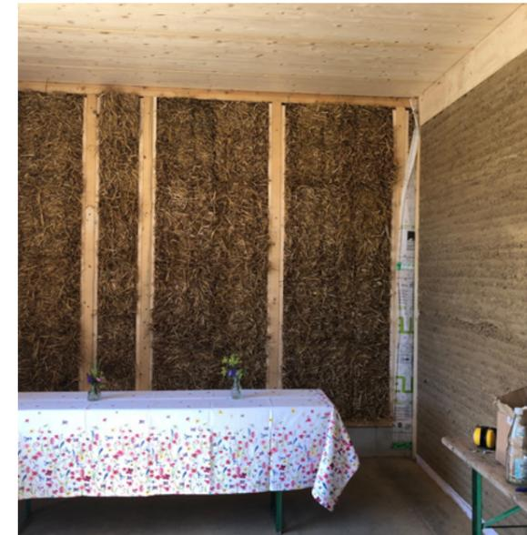
Eine Außenwand wurde mit Stroh gedämmt. In den zweischalig angelegten übrigen Außenwänden kamen zur Dämmung Jutematten und eine Zellulose Einblasdämmung zum Einsatz
