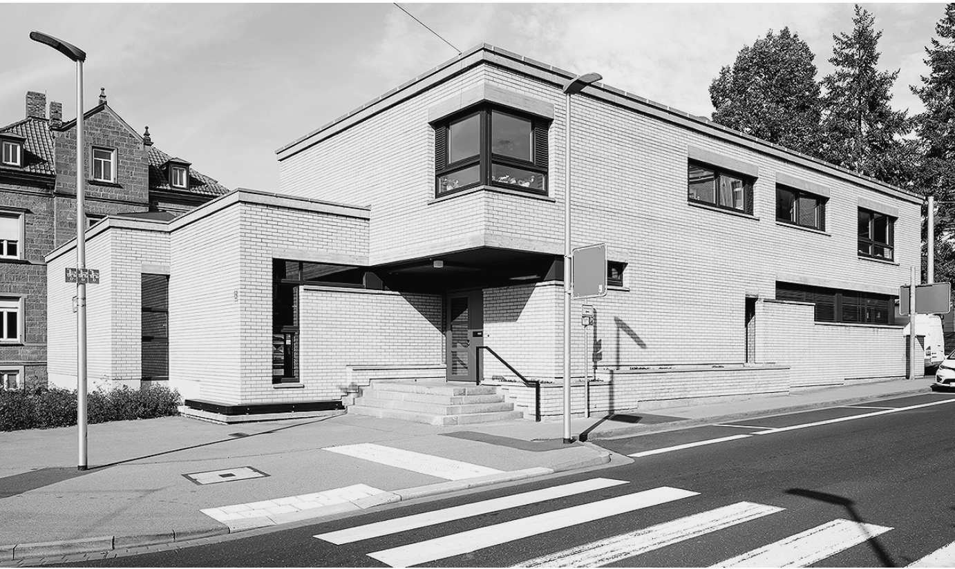
Sowohl die Fassade als auch Fensterrahmen und Tür hatten ihre einstige Farbigkeit verloren und waren stark verschmutzt. Heute erstrahlt das Gebäude an der vielbefahrenen Straßenkreuzung in Bad Kissingen in neuem Glanz. FOTO: STEFAN MEYER
