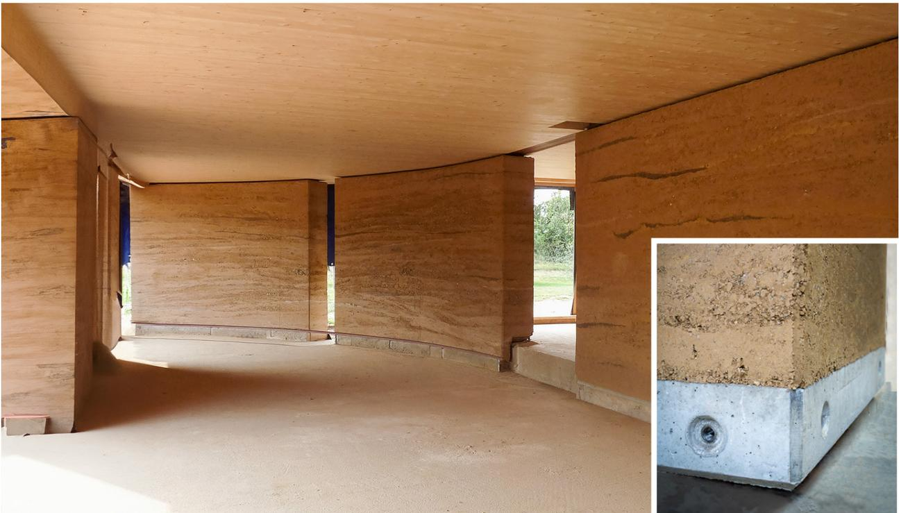
Um nachhaltiges und ökologisches Bauen schneller und einfacher zu machen, bietet conluto vorproduzierte Fertigelemente aus Stampflehm. Die Elemente bieten eine effiziente und nachhaltige Lösung für alle Bauprojekte. Die Fertigelemente werden energiearm und industriell vorgefertigt. Sie sind langlebig, zirkulär und vollständig wiederverwertbar, sie weisen eine hohe Ästhetik auf, sind robust, warm und wirken monolithisch. Ihre besondere Textur macht sie einzigartig.
