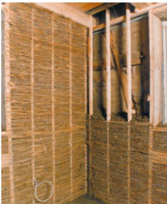
Blähton-Leichtlehm wird als plastisches Material zum Verfüllen hinter der verlorenen Schale verwendet.
