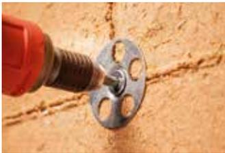
Befestigung der Lehmbauplatten mit Schrauben und Haltetellern
