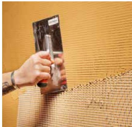
Das Glasgittergewebe muss immer 10 cm überlappend verlegt werden. Hierfür besitzt das conluto Glasgittergewebe eine Markierung. Wie im Trockenbau üblich, darf nur dünnlagig auf der Lehmbauplatte gearbeitet werden.
