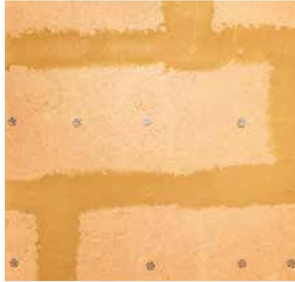
Zur Verlängerung der Bearbeitungszeit kann die Fläche einfach mit einer Drucksprühflasche leicht angefeuchtet werden (nicht nass!). Ist die Fugenspachtelung trocken, kann mit der Armierungslage begonnen werden.
